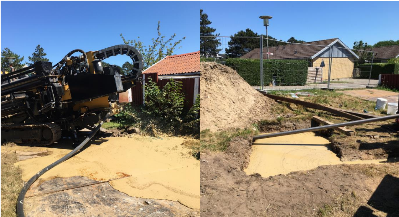
Boreriggen og borerør placeret på stationsiden. Herfra bores der ca. 400 m under jernbane og Gilleleje Stationsvej/Alfavej.
