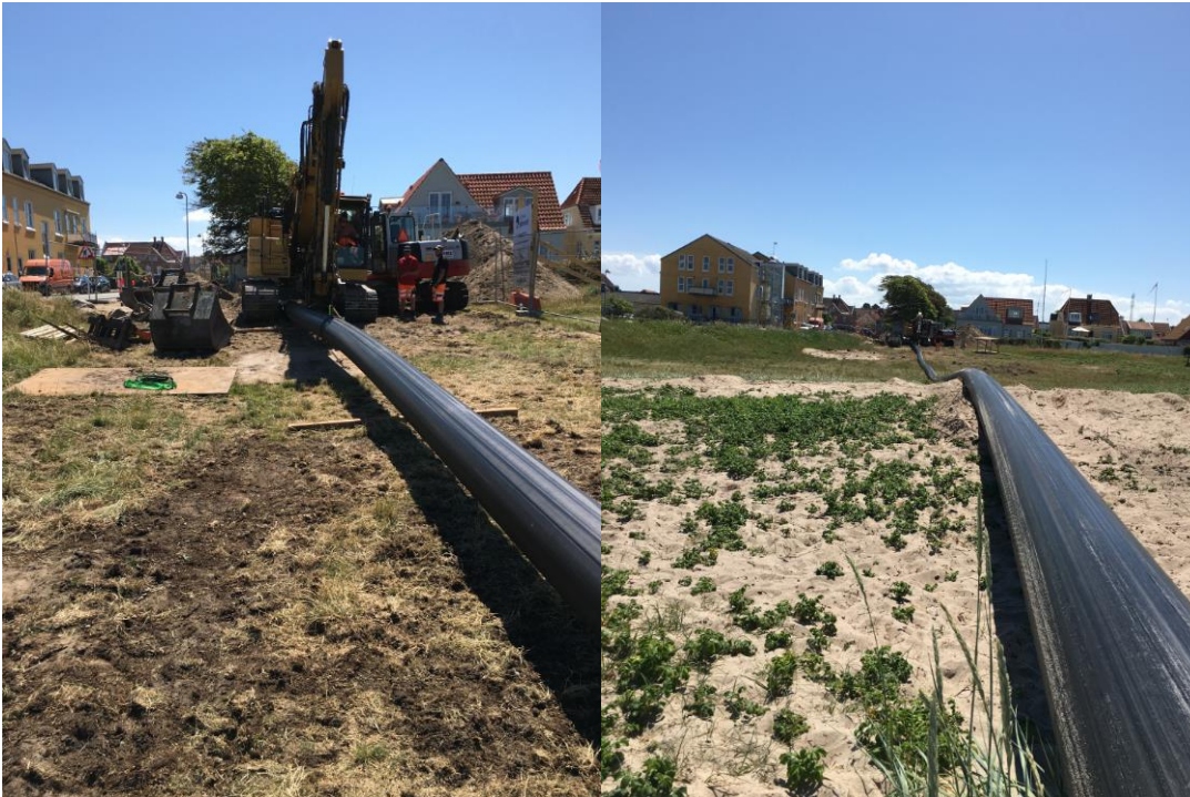
Havledning \varnothing 400mm på stranden. Vakte opsigt og spørgsmål fra strandgæsterne.
